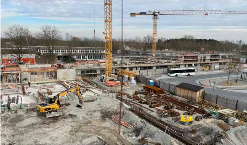
Rietbergs größte Baustelle seit Langem, ist der Neubau des Gymnasiums am Torfweg. Hier entsteht ein ca. 240 m langer, 3 geschossiger Stahlbetonbau mit über 12.300 m<sup>2</sup> Geschossflächen in 10 Monaten Rohbauzeit.
